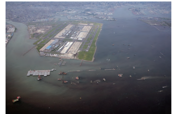
2008年6月24日撮影 提供：羽田再拡張D滑走路JV
