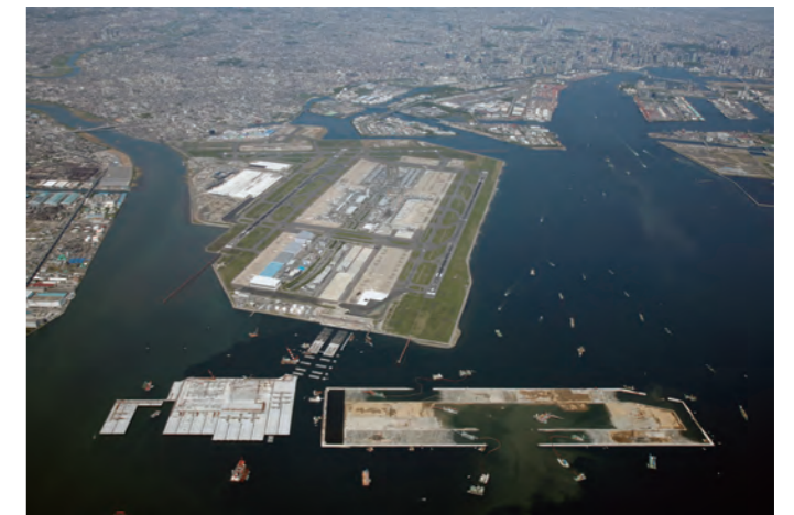
2009年4月27日撮影 提供：羽田再拡張D滑走路JV
