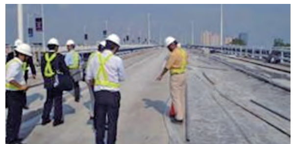
写真-6 現場視察状況
