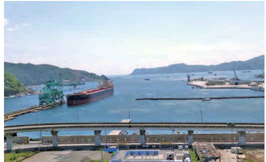
写真-2 湾口防波堤と防潮堤による多重防護(釜石港)
