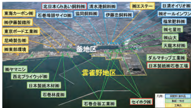
写真-3 港湾背後の50社のうち48社が操業再開(石巻港)
