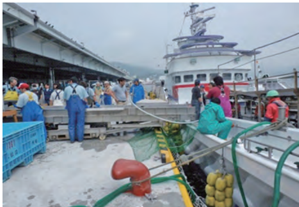
カツオの水揚げで利用される復旧後の岸壁 (平成26年6月気仙沼漁港で撮影)
