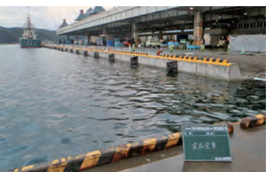
工事名 平成23年度気仙沼漁港-6m岸壁災害復旧工事 発注者 水産庁 工期 2012年2月28日～2013年3月27日 施工場所 宮城県気仙沼市
