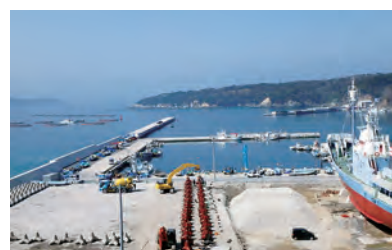
工事名 鮎川漁港南防波堤外災害復旧工事 発注者 宮城県 工期 2012年6月19日～2014年7月31日 施工場所 宮城県石巻市鮎川浜
