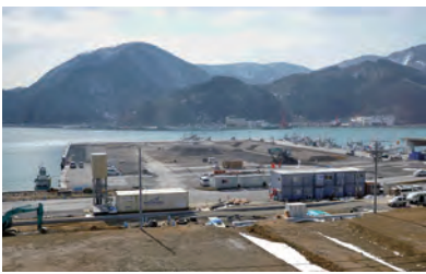
工事名 女川漁港宮ヶ崎岸壁外災害復旧(その3)工事 発注者 宮城県 工期 2013年2月8日～2013年5月31日 施工場所 宮城県牡鹿郡女川町
