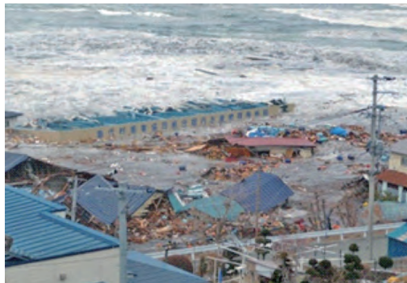
東日本大震災の津波の来襲状況(岩手県太田名部漁港) 提供 普代村漁業協同組合
