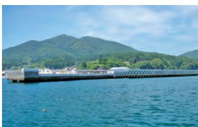
工事名 大船渡漁港災害復旧(23災第503号ほか)工事 発注者 岩手県沿岸広域振興局 工期 2012年12月11日～2014年7月27日 施工場所 岩手県大船渡市末崎町
