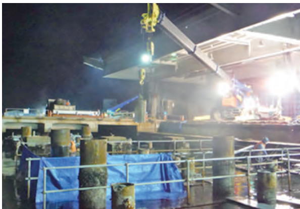
潮位の低い夜間に鋼管杭の継杭を行った栈橋式岸壁の復旧工事
