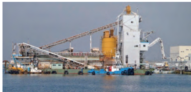
ミキサー船による水中コンクリート打設を行った重力式岸壁の復旧工事
