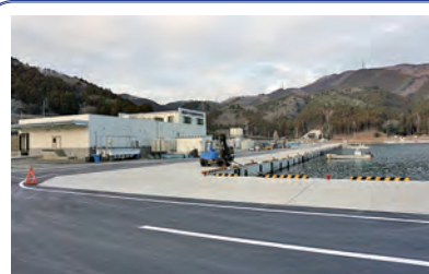
工事名 桃ノ浦漁港-2.0m物揚場外災害復旧工事 発注者 宮城県 工期 2012年10月12日～2015年3月20日 施工場所 宮城県石巻市桃浦
