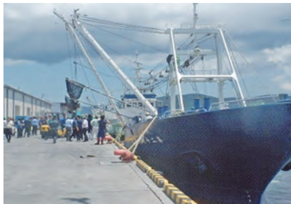
カツオの水揚げで利用される復旧後の岸壁 (平成26年7月石巻漁港で撮影)
