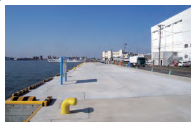
工事名 塩釜漁港新浜町三丁目岸壁(6.0m)外災害復旧工事 発注者 宮城県 工期 2013年02月21日～2015年03月27日 施工場所 宮城県塩釜市
