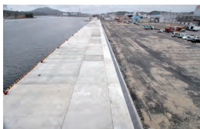
工事名 平成23年度気仙沼漁港-6m 栈橋災害復旧工事 発注者 水産庁 工期 2012年3月3日～2013年5月31日 施工場所 宮城県気仙沼市
