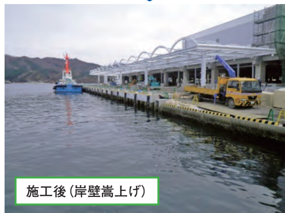
新大船渡魚市場前岸壁の満潮時冠水解消
