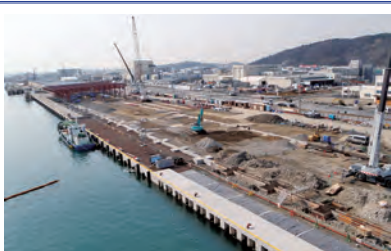
工事名 平成24年度石巻漁港重力式岸壁災害復旧工事 発注者 水産庁 工期 2013年2月20日～2014年7月31日 施工場所 宮城県石巻市
