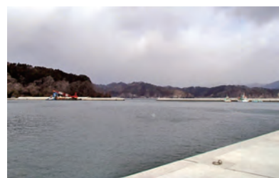
工事名 箱崎漁港災害復旧(23災第529号ほか)工事 発注者 岩手県 工期 2013年03月12日～2015年03月20日 施工場所 岩手県釜石市箱崎町
