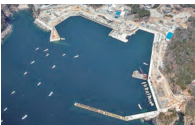
工事名 寄磯漁港東A防波堤外災害復旧工事 発注者 宮城県 工期 2012年10月12日～2014年11月28日 施工場所 宮城県石巻市
