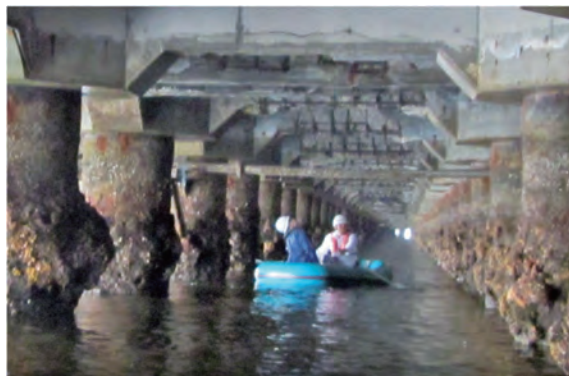
写真-1 港湾の施設の点検状況
