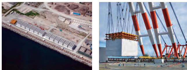
写真-7 陸上ヤードでのケーソン製作状況(左)（撮影：平成 25 年 9 月）と大型起重機船によるケーソン吊上げ状況(右)（撮影：平成 25 年 12 月）
