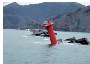
写真-4 湾口防波堤の被災状況 (撮影：左・平成23年4月、右・平成23年3月)
