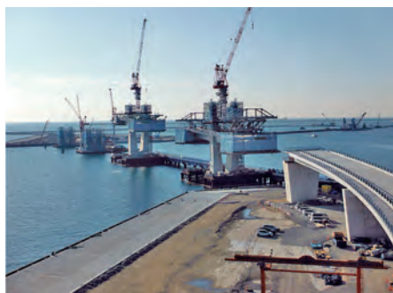
写真-9 橋梁施工状況(撮影:平成26年2月)
