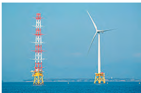
着定式洋上風力発電施設(北九州市沖) 提供：NEDO
