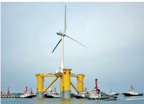
浮体式洋上風力発電設備を曳航する様子
