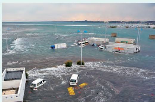
大洗港区の津波の被災状況
