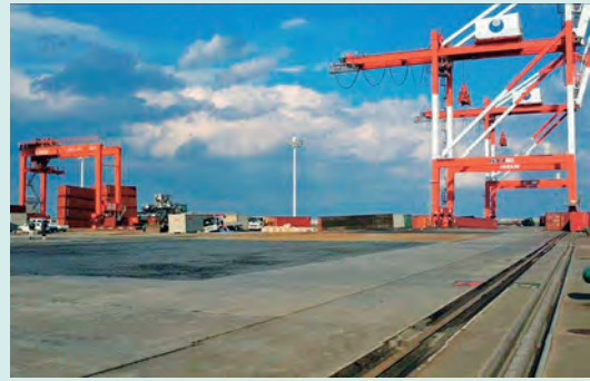
常陸那珂港区北ふ頭外貿の復旧後の状況
