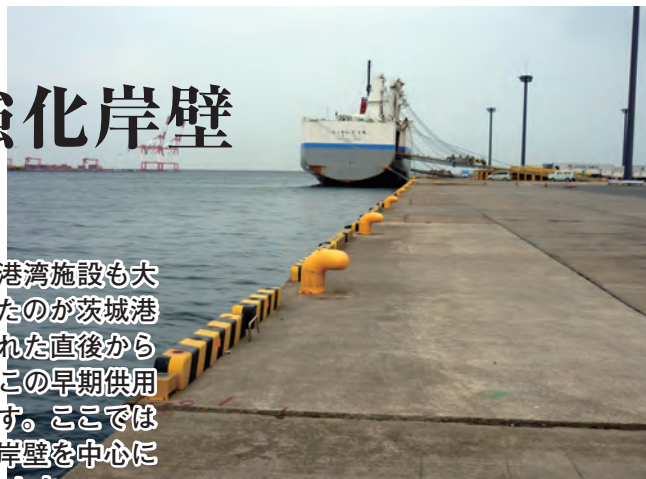
早期供用を再開したA岸壁（手前部分）
