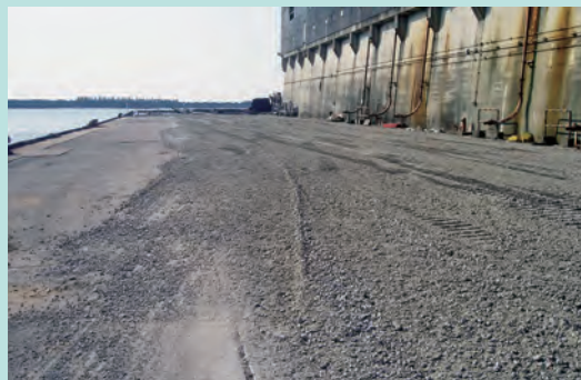
日立港区第1ふ頭1-BC岸壁の復旧後の状況
