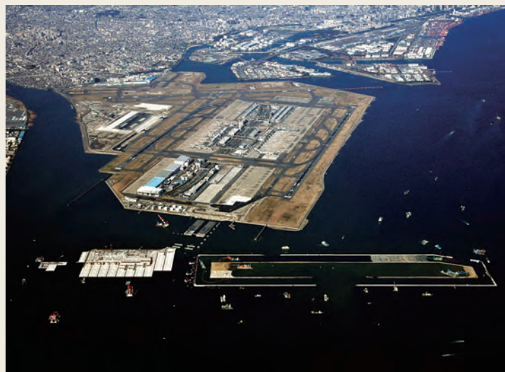
中仕切り堤の内部に陸地が現れはじめる
