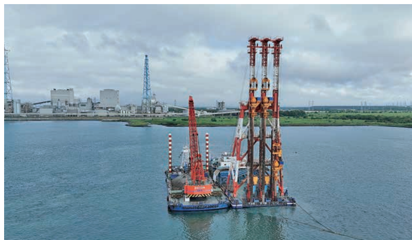
周文ふ頭工事(R6サンドコンパクション船)
