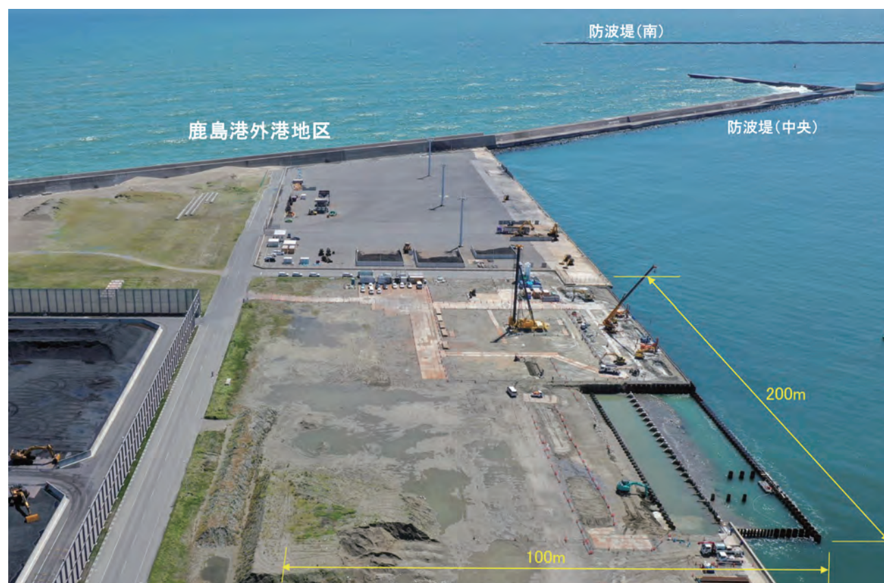
風力発電設備基地港湾の整備が進む
