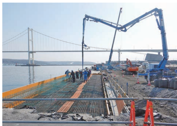
祝津ふ頭岸壁改良工事での上部工コンクリートの打設作業
