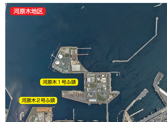
ポートアイランドは第2期工事までが完了
