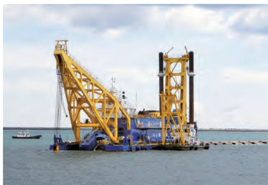
八戸港の航路泊地整備に活躍するポンプ浚渫船
