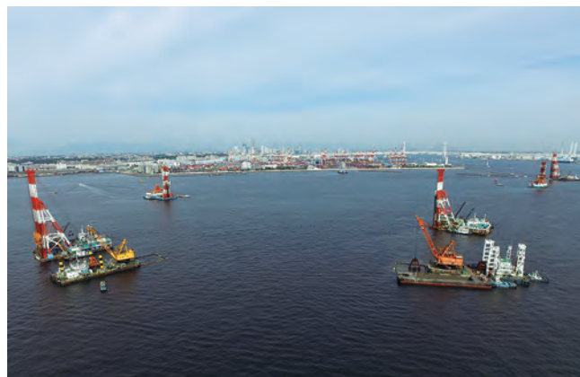
地盤改良が進む新本牧ふ頭地区
