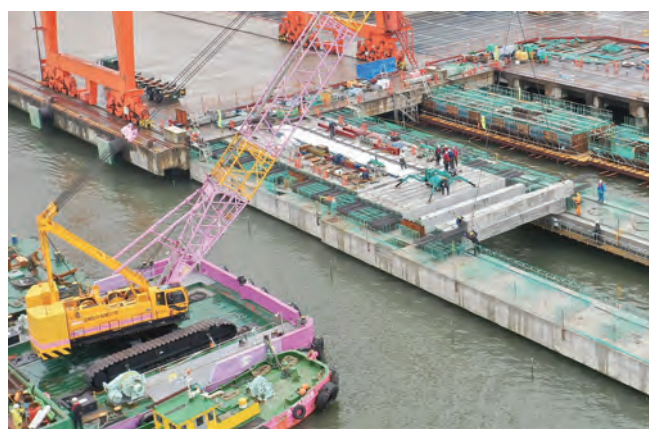
飛島ふ頭東地区ではR1岸壁の上部工に着手(PC桁据え付け状況)
