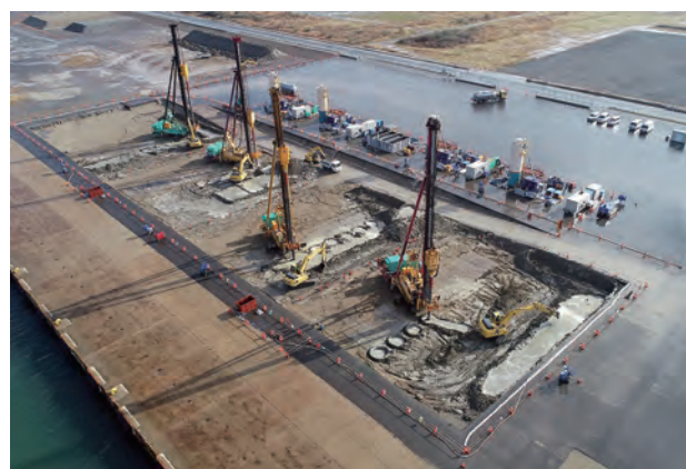
ふ頭用地の地耐力を高める地盤改良工事
