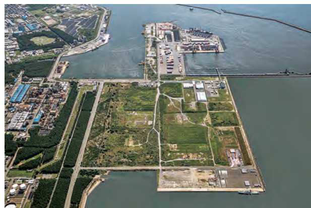
洋上風力発電の作業基地と想定される飯島地区の岸壁(右下)
