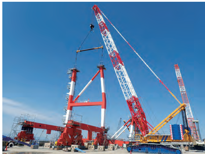
ガントリークレーンの組立作業
