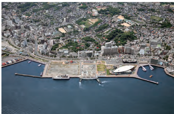
東港地区。右側の白い施設が水族館「海響館」 提供：下関市
