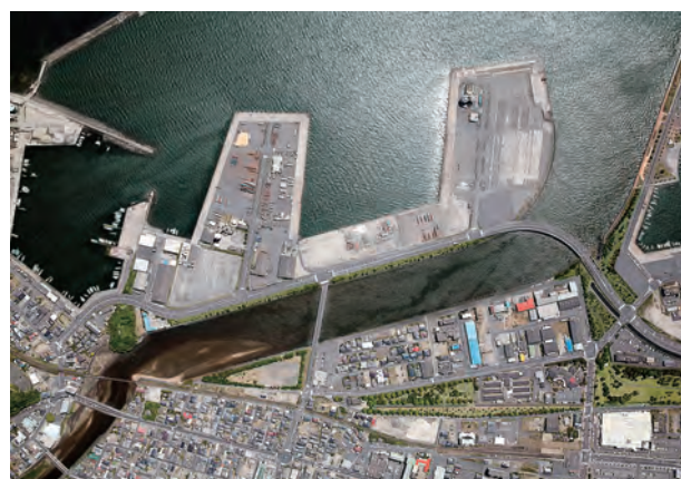
外港地区（左側が第一突堤、右側が第二突堤）提供：鹿児島県
