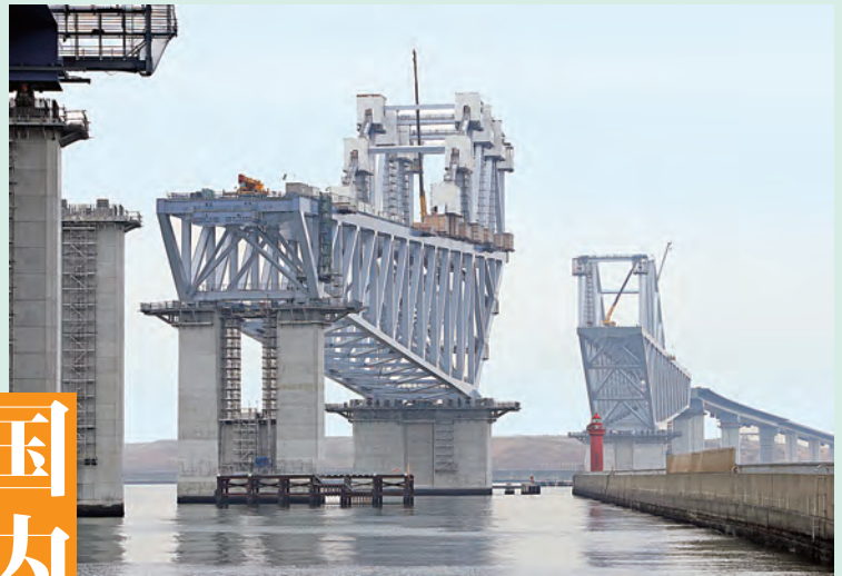
建設中の東京港臨海大橋(仮称)
