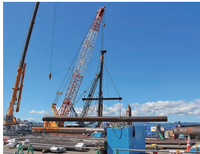
鋼管矢板加工ヤードでの作業状況
