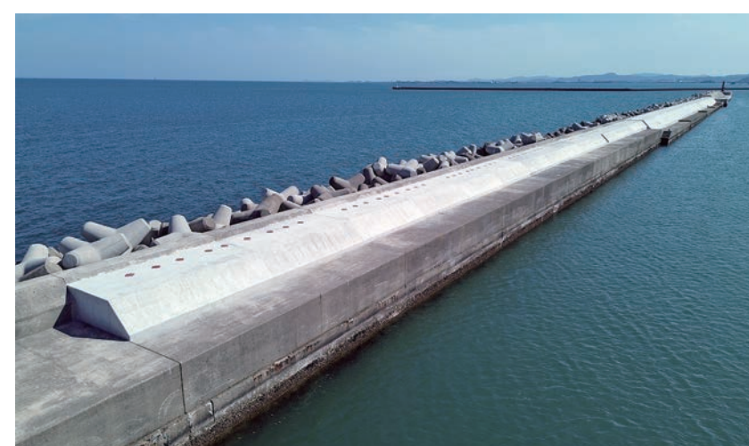
「粘り強い構造」への改良が進む沖洲(外)地区防波堤
