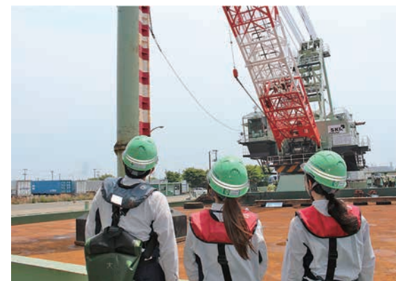
作業に向けて待機する起重機船も見学
