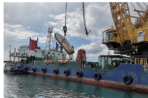
【左上写真】輪島港 地盤隆起により水深が浅くなった漁船だまりで漁船が移動できるよう浚渫を行っている様子（6月30日撮影） 【左下写真】飯田港 津波により船だまりに浮遊している漁船を引き揚げる作業（航路啓開）を行っている様子（3月22日撮影）
