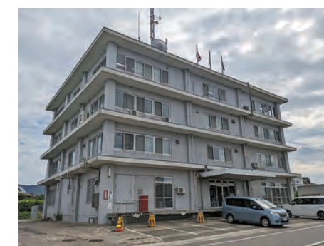
能登港湾空港復興推進室が入る七尾港湾合同庁舎（石川県七尾市）
