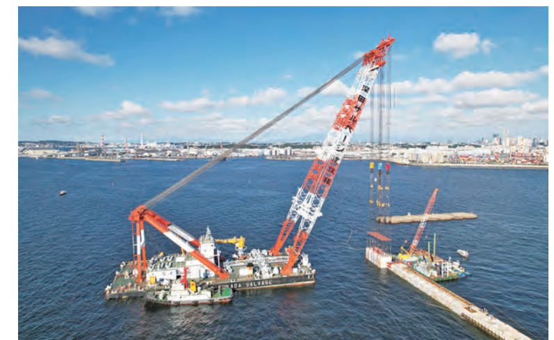
現地でのケーソン据付状況
