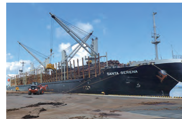
【右上写真】七尾港 大田物資専用岸壁の背後で液状化による沈下で水たまりが発生（1月2日撮影） 【右下写真】七尾港 大田3号岸壁の応急復旧後、震災前と同様の大型原木船が初めて入港し、荷役作業を行っている様子（6月3日撮影）
