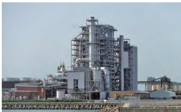
石巻ひばり野バイオマス発電所
