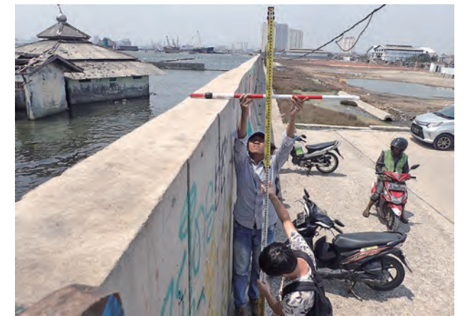
地盤沈下が進むインドネシア・ジャカルタの新設防潮堤
