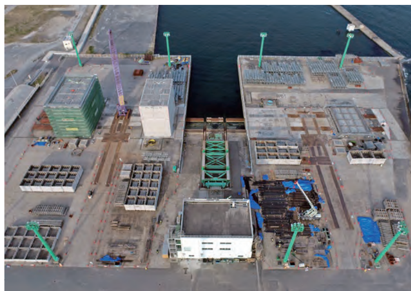
ケーソンヤード全景
