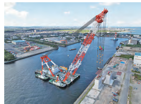
ケーソン据付準備(吊降し方式)状況
