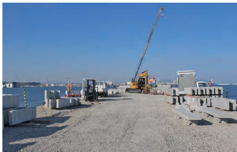
ケーソン上部工の施工状況
