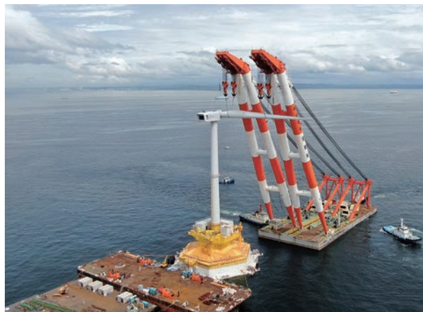
福島県沖での浮体式洋上風力発電システムの実証研究事業 (5MW 風車解体状況)
