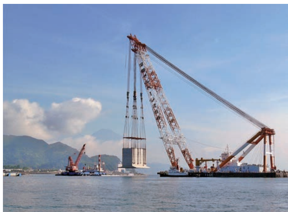
海上でのケーソン据え付け(三河港)
