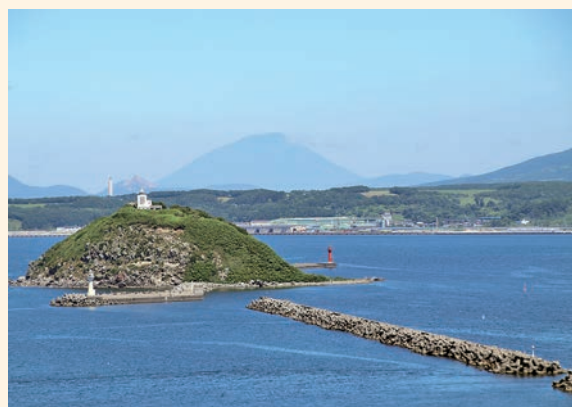
施設群の一つである大黒島灯台(島の頂上部)
