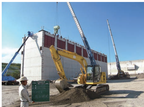
ケーソンへのバラスト投入状況(三河港)
