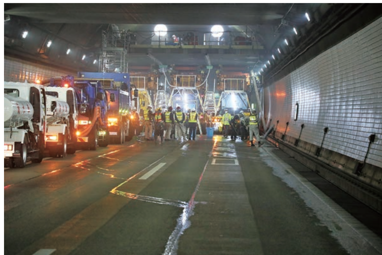
熱気あふれるトンネル内での夜間工事
