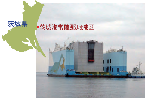
茨城県 茨城港常陸那珂港区 ケーソン専用進水台船(DCL)でケーソンを曳航
