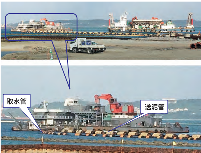
写真-1 空気圧送船による揚土
