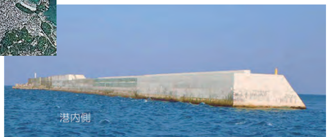
南沖防波堤の現況
