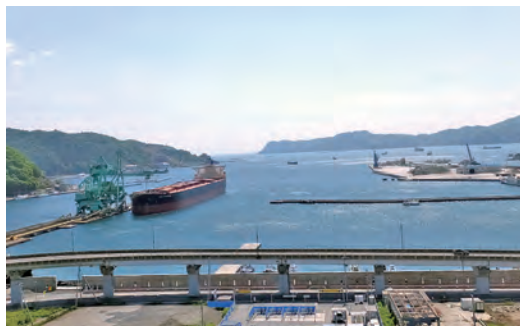
写真-2 湾口防波堤と防潮堤による多重防護(釜石港)
