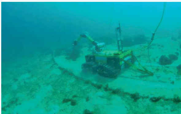
写真-8 海底ケーブル調査状況
