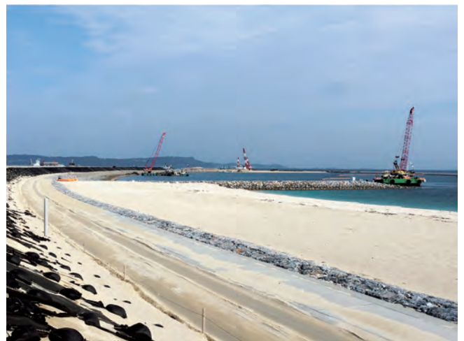
写真-2 人工ビーチの施工状況
