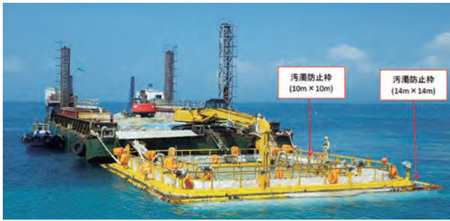
図-4 バックホウ浚渫作業の状況 4)
