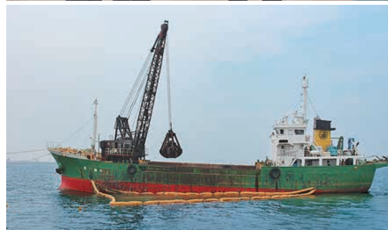
現場でガット船による捨石投入(下)を説明
