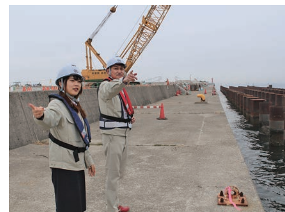
工事の状況を見学
