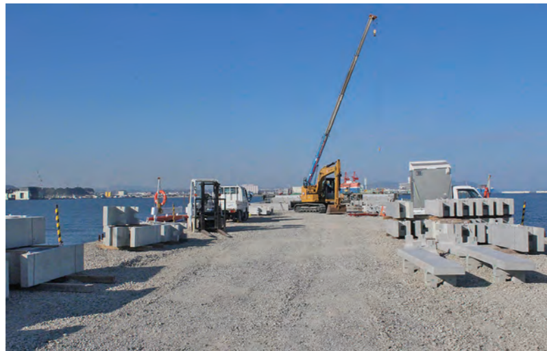
ケーソン上部工の施工状況
