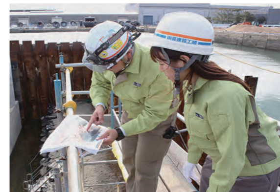
効率的な作業手順についての説明を受ける
