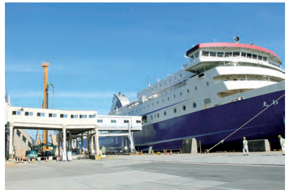
カーフェリー着岸時(4号岸壁)
