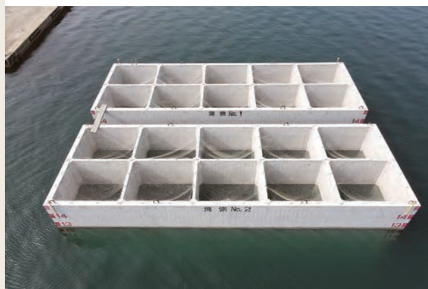
仮置きが完了した2函のケーソン
