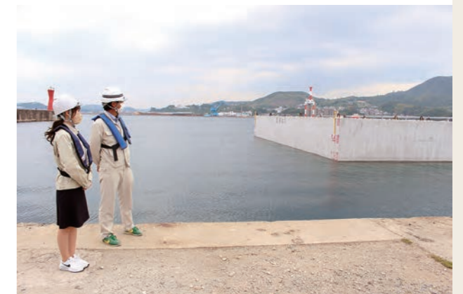
実物を前に施工手順の説明を受ける
