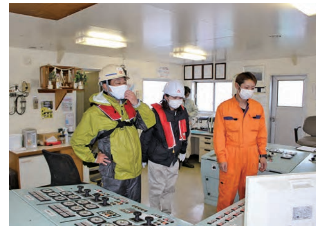
操作室で揚土作業の説明を受ける
