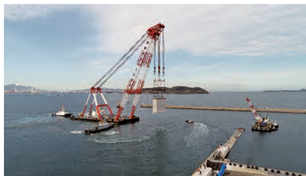
ケーソン曳航・据付状況
