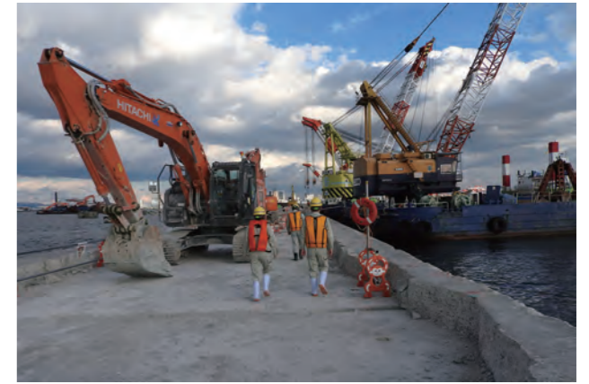
防波堤の幅は狭く、作業の安全性確保が課題となる
