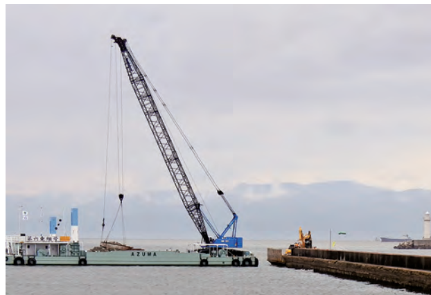
航路を広げるため古い防波堤の撤去が着々と進む
