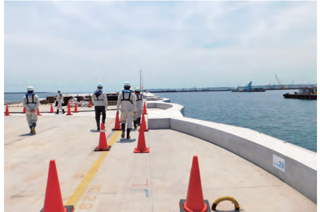
直径21mのセルは処分場全体で77函設置される
