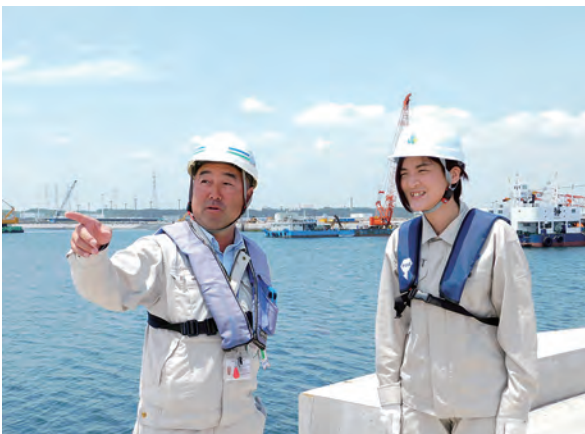
護岸の上部で施工手順の説明を受ける田坂さん
