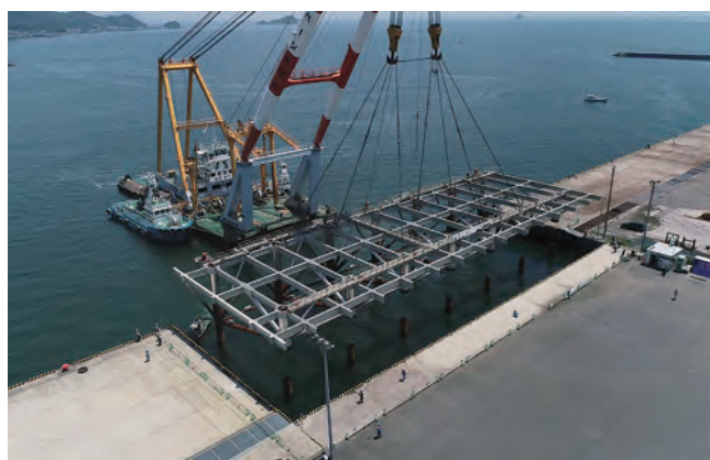
700t吊りクレーンによるジャケットの据え付け作業
