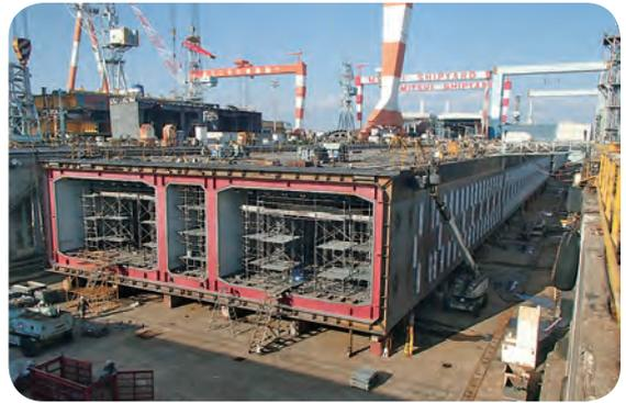
ドックで組み立て中の沈埋函
