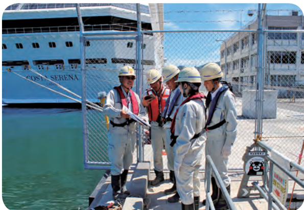
供用中の岸壁の改良工事には様々な制約が伴う
