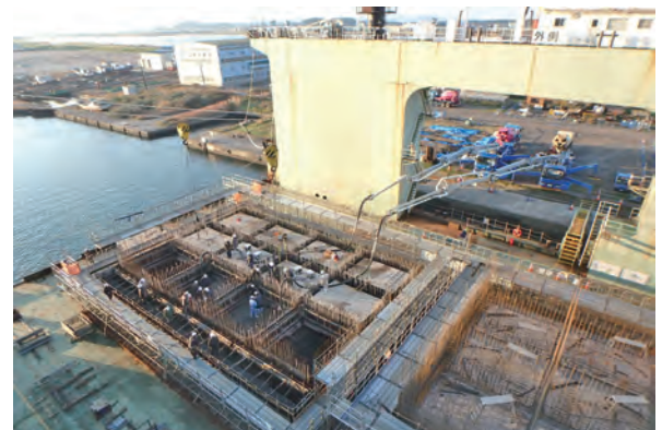
鉄筋と型枠を組んでコンクリートを打設
