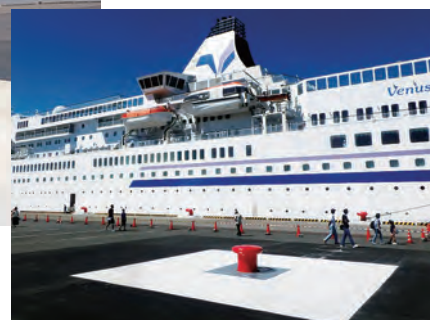
木更津港に試験入港したばしふいっくびーなす (写真手前が新設した係船直柱)
