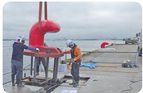
大型係船曲柱の設置作業状況
