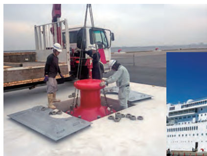
係船直柱を据え付ける様子
