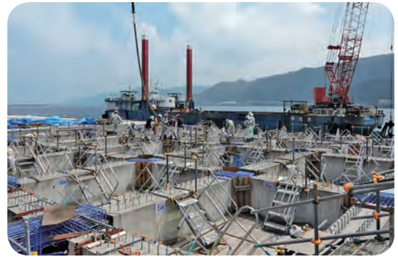
上部工新設に向けたコンクリート打設作業
