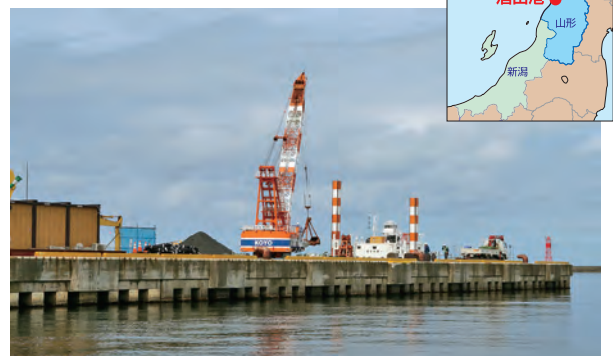
国際ターミナルの既設岸壁。延伸させるためケーソン2函を据え付ける。
