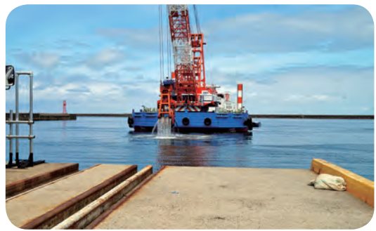
ケーソンの基礎マウンドを構築するための床掘作業。
