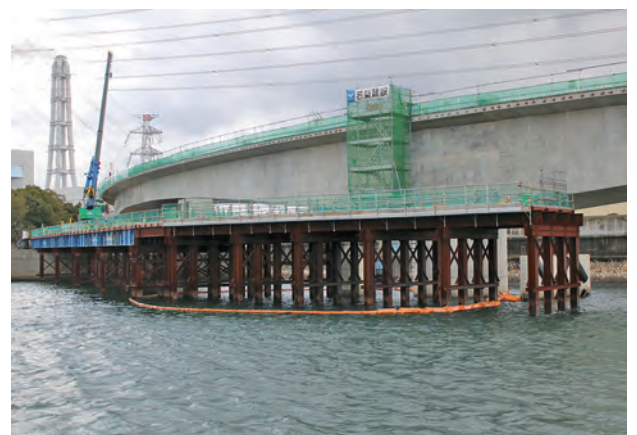
完成に向け工事は佳境を迎えている
