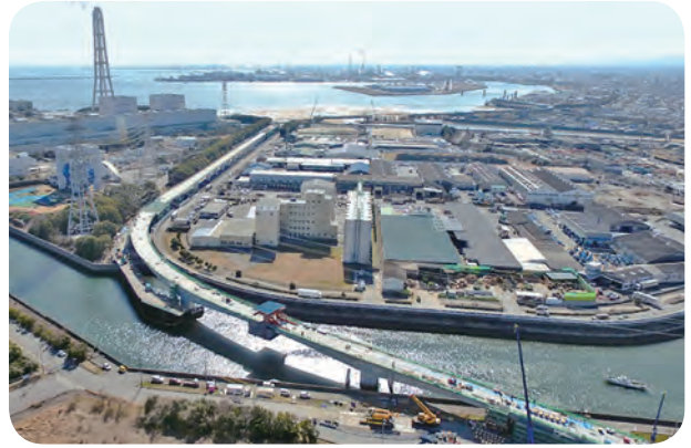
ドローンで撮影した現場の全景
