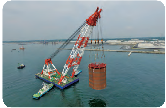
起重機船で鋼板セルを設置する様子
