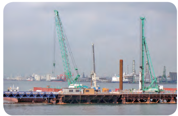
鋼管矢板の打設状況
