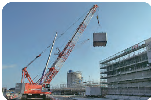
鋼製型枠を設置する様子
