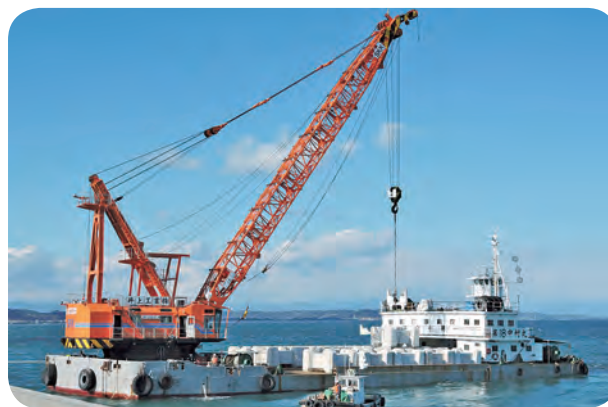
現場据付に向けたブロック積み出し作業の様子
