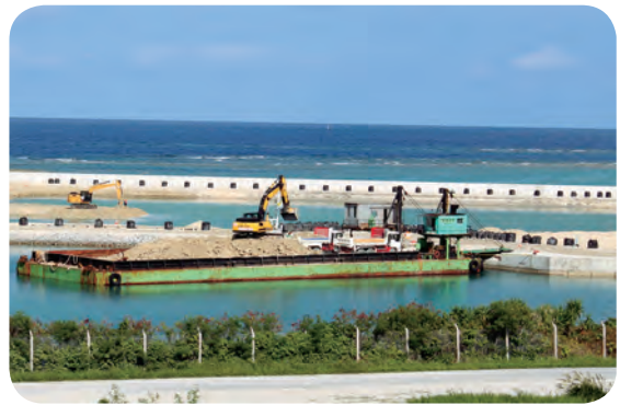
埋立工事が進む施工現場
